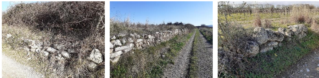
Figure 13 : Photographies prises sur le terrain Quelques exemples du fin travail de topographie et du lien récurrent entre chemins, fossés et petits murets de soutènements, Ici et Là Paysage
