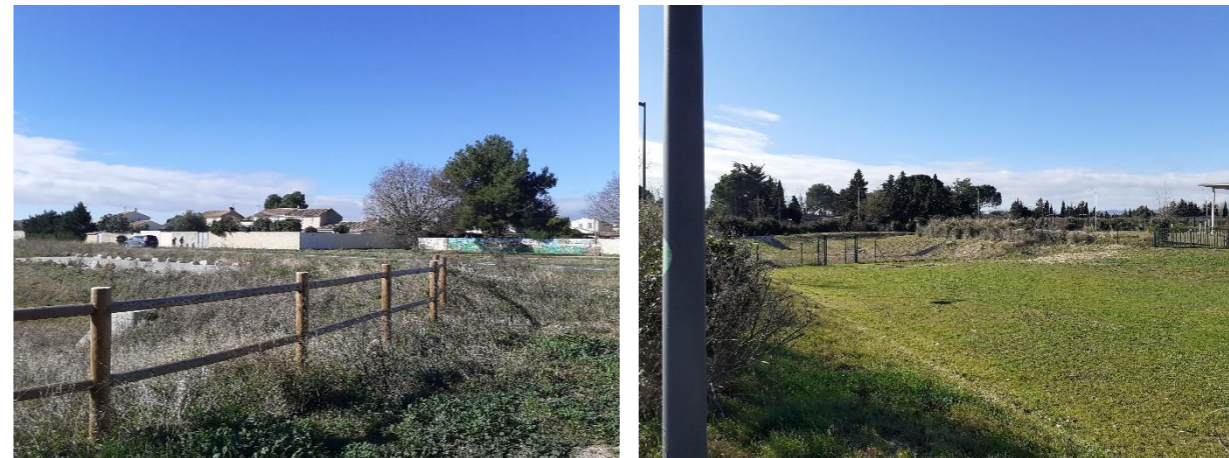
Figure 16 : Photographies prises sur le terrain La bassin de rétention au nord, entouré d'un garde-corps bois, et celui lié à la piscine au sud, Ici et Là Paysage
