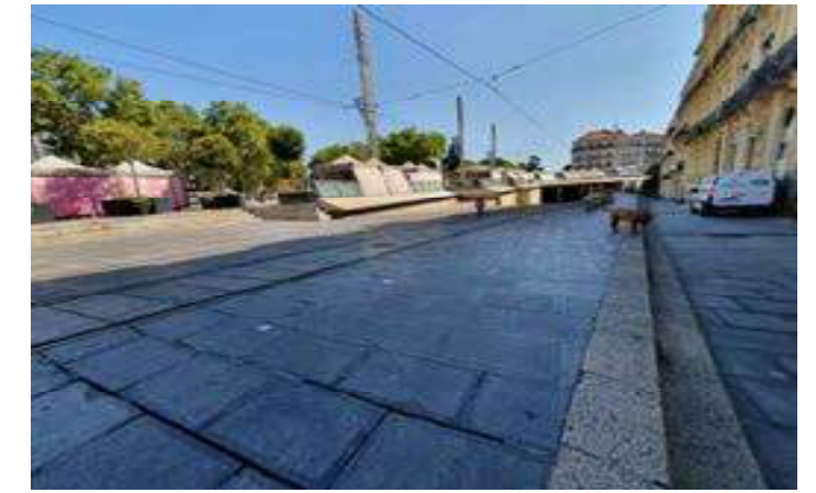
Figure 3 : Voie de tram sur la place de la Comédie
