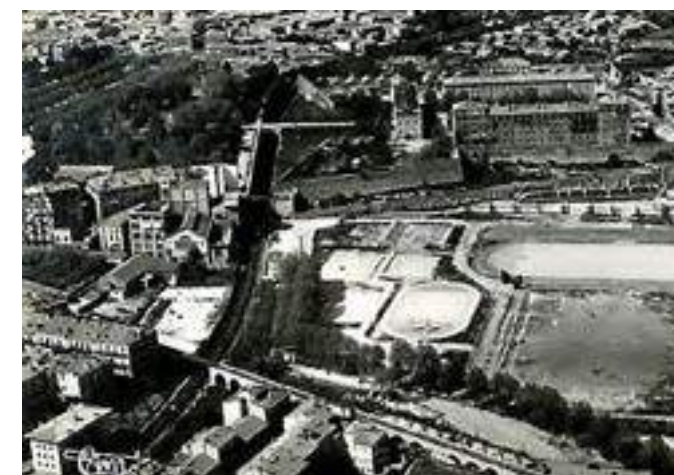
Années 1950 – Aménagements de l'armée et viaduc du train pour Palavas
