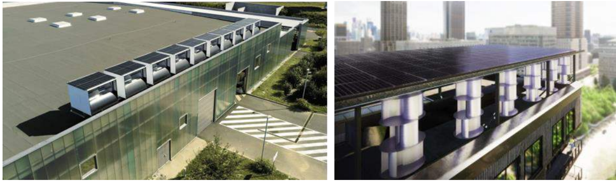
Figure 8 : Exemple d'installations de petit éolien urbain
