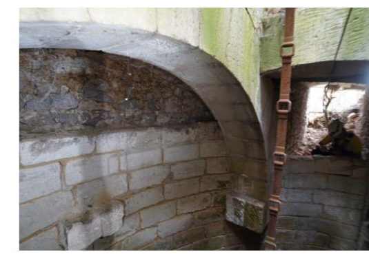
Fig.25. Le puits. L'espace voûté entre le cuvelage supérieur et l'arc doubleau de la margelle. Cl. C. Bois, 2021
