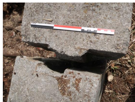
Fig.50. Le mur du bassin, mur M2. Tenon et mortaise déconnectés. Cl. V. Rousset, 2021
