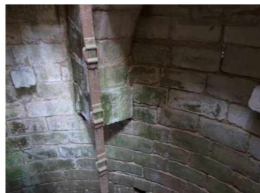
Fig.20. Le puits. Le corbeau, Co6, à droite. Le corbeau Co5, à gauche. Cl. V. Rousset, 2021
