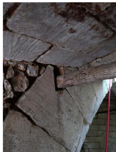
Fig.30. Le passage voûté. Empochement sud pour une poulie. Cl. V. Rousset, 2021
