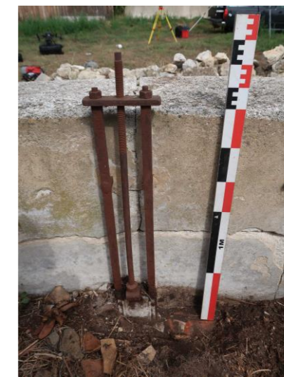
Fig.52. La vanne nord du bassin. Cl. V. Rousset, 2021
