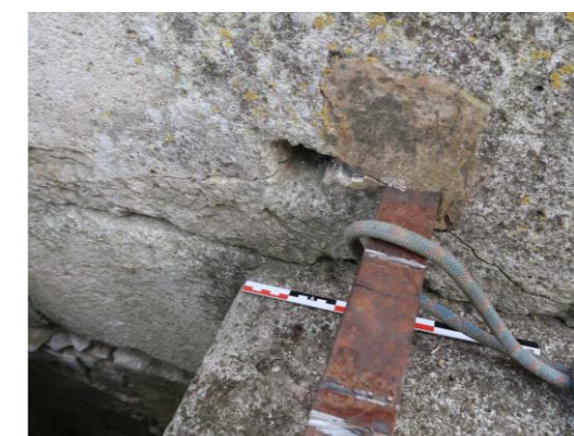
Fig.38. La face nord de l'aileron ouest de la potence. Trou de scellement. V. Rousset, 2021
