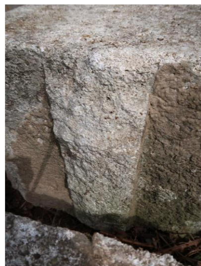
Fig.48. Le mur du bassin, mur M2. Tenon en pierre arraché. Cl. V. Rousset, 2021
