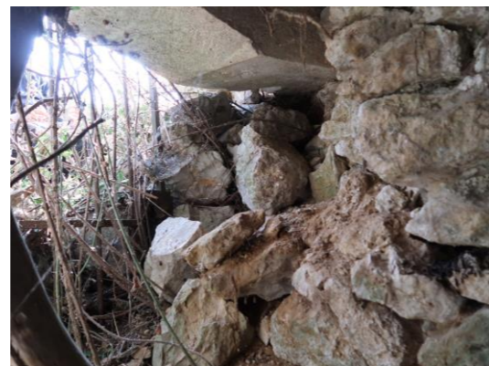
Fig.29. La porte P1 vue du passage voûté. Cl. V. Rousset, 2021
