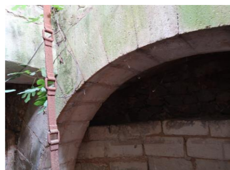
Fig.44. La chaîne à godets vue depuis l'intérieur du puits. Cl. V. Rousset, 2021
