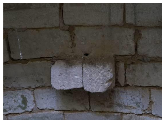
Fig.19. Le puits. Le corbeau, Co6, et l'orifice d'une conduite. Cl. V. Rousset, 2021
