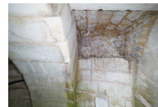
Fig.27. Le puits. La voûte ouest, V3, entre les deux arcs doubleaux. Cl. C. Bois, 2021
