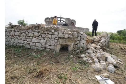
Fig.60. Mur de la piste. Niche N1, au nord. Cl. C. Bois, 2021
