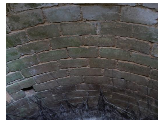
Fig.15. Le puits. Empochement E1 (nord-ouest). Cl. V. Rousset, 2021
