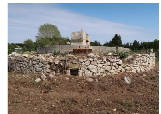
Fig.65. Mur de la piste. Niche N3, à l'ouest. Cl. V. Rousset, 2021
