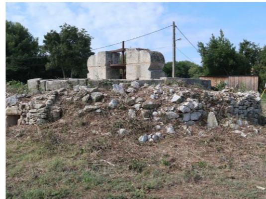
Fig.59. Le parement extérieur du mur, M1, de la piste. Vue d'ensemble de l'éboulis correspondant à l'ancienne rampe. Cl. V. Rousset, 2021
