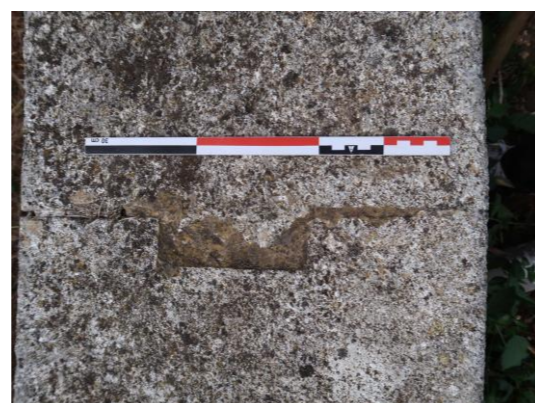
Fig.49. Le mur du bassin, mur M2. Tenon et mortaise en connexion. Cl. V. Rousset, 2021
