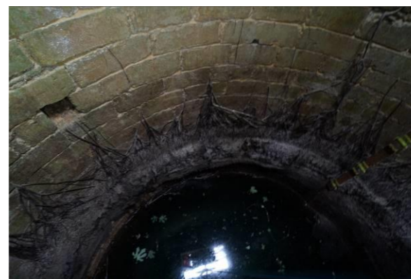
Fig.13. Le fond du puits. Cl. C. Bois, 2021
