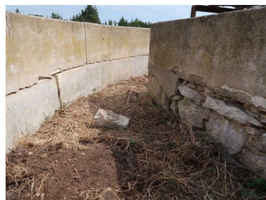
Fig.47. Le mur M2, vu depuis l'intérieur du bassin. Cl. V. Rousset, 2021
