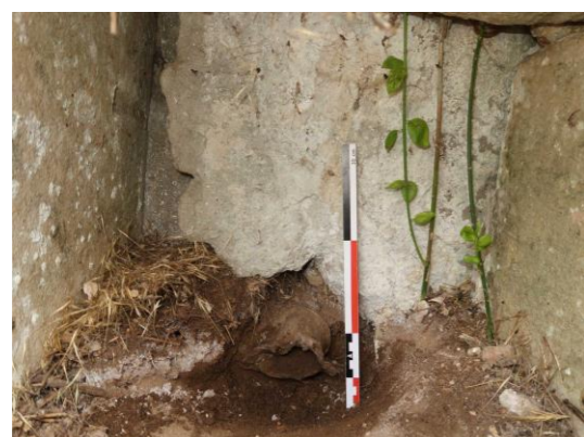
Fig.66. Mur de la piste. Niche N3, à l'ouest. Cl. V. Rousset, 2021
