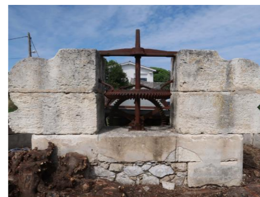
Fig.36. La margelle et la potence en pierre vues du sud. Maçonnerie moellonnée et en pierre de taille. Cl. V. Rousset, 2021
