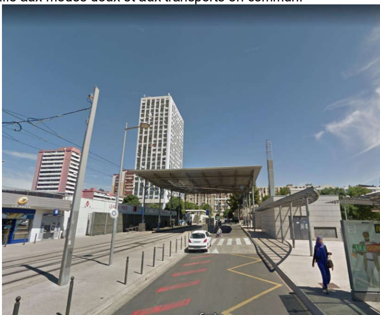
Vue actuelle de l'entrée de ville, donnant sur l'auvent du tramway et la Tour d'Assas
