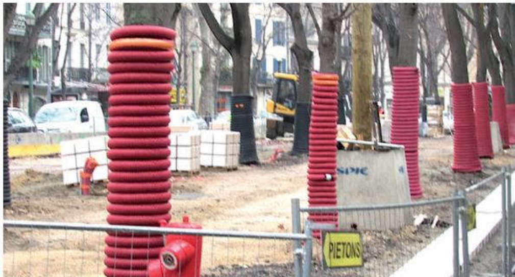
Exemple de protection du tronc avec des tuyaux enroulés (source : objectif Gard)
