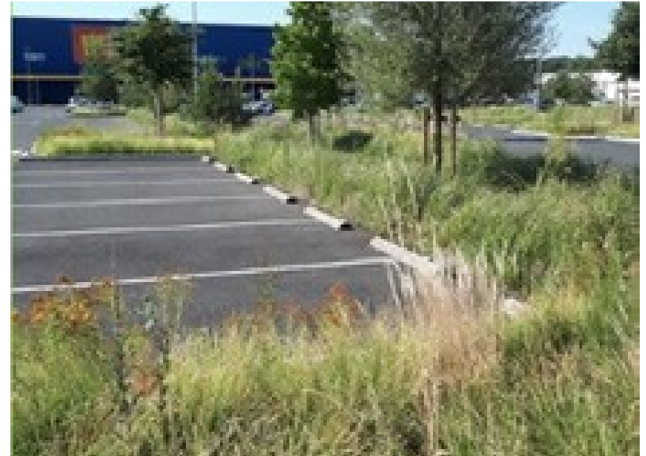
Bordures abaissées ou discontinues
