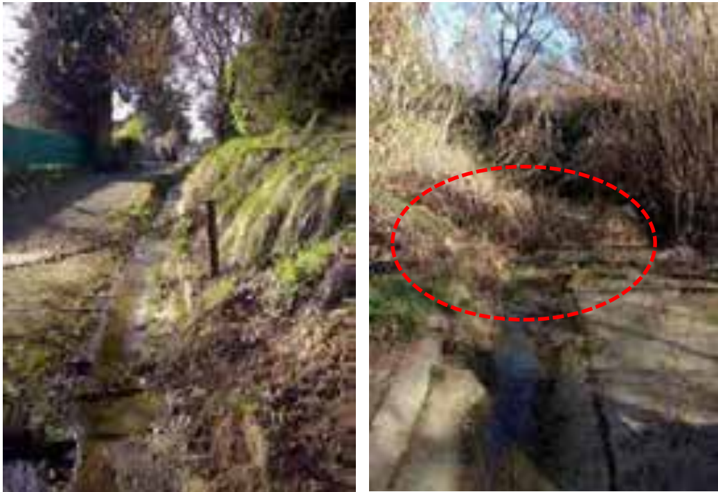
Caniveau (vue vers l'amont)
