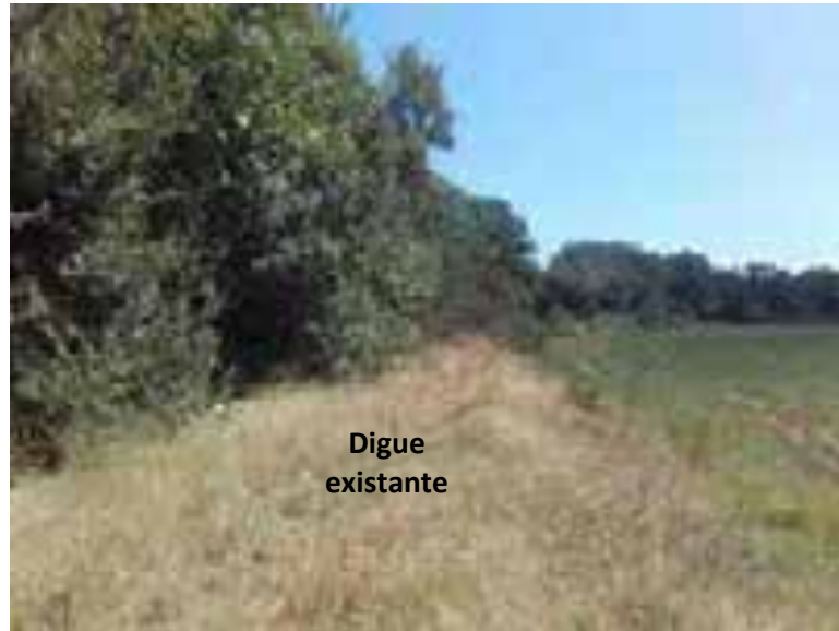
Figure 8 : Vue de la digue existante
