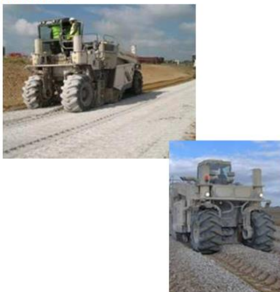
ENGINS DE CHANTIER UTILISES POUR LE TRAITEMENT DES REMBLAIS
