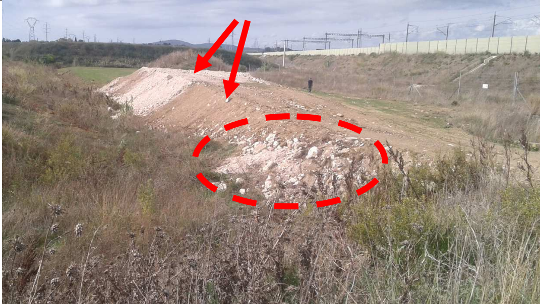
Vue depuis le stock n°1 en direction de l'Ouest sur le stock n°2
