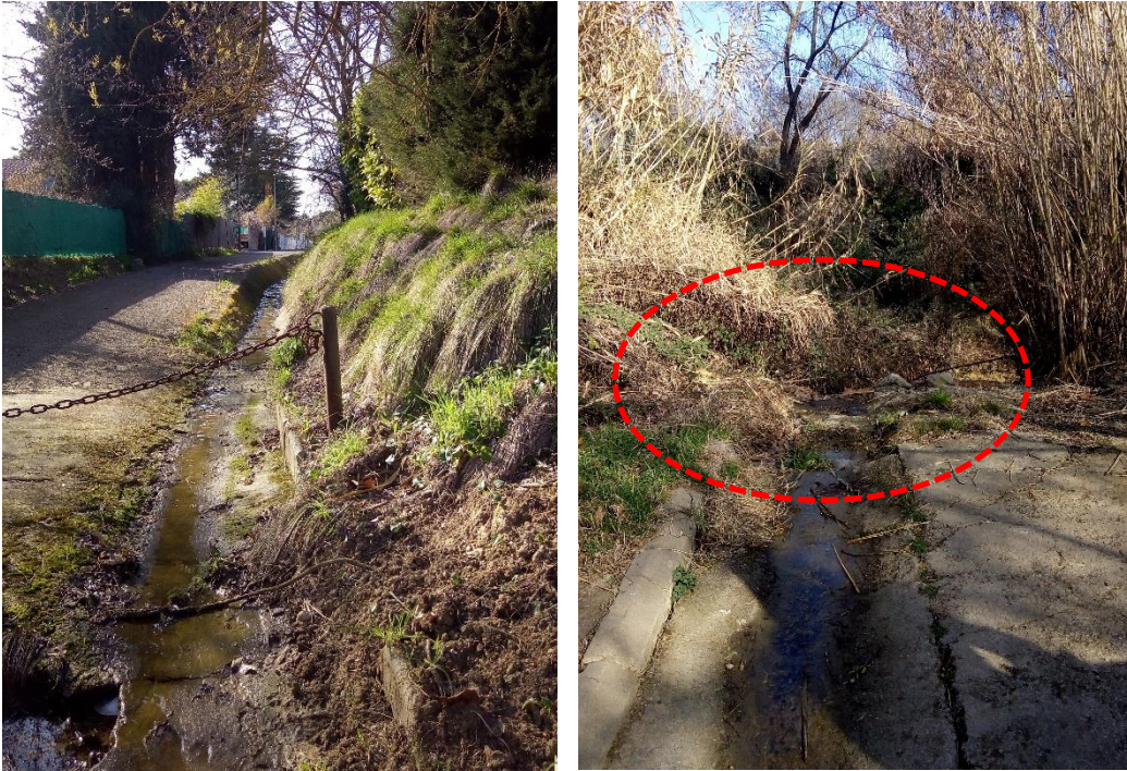
Caniveau (vue vers l’amont)
