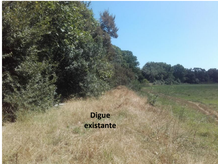
Figure 8 : Vue de la digue existante
