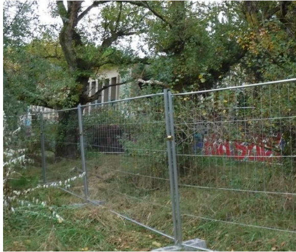
Exemple de barrières de chantier pour protéger un groupement arboré (CBE 2018)
