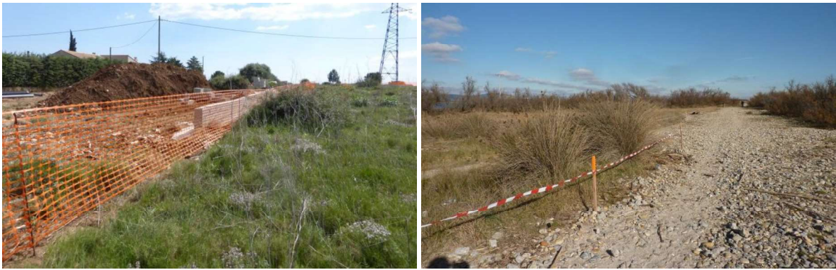
Exemple de balisage avec une clôture souple de chantier, à gauche, ou avec de la rubalise, à droite (CBE 2017 et 2015)
